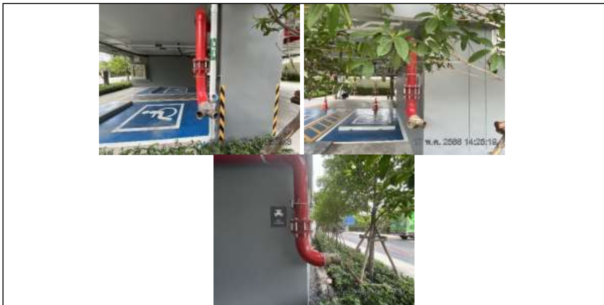
รูปที่ ผ7.58 หัวรับน้ำดับเพลิงภายนอกอาคาร (Fire department connector : FDC)
